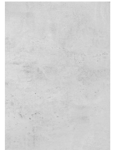
주차장 바닥 : 콘크리트폴리싱
